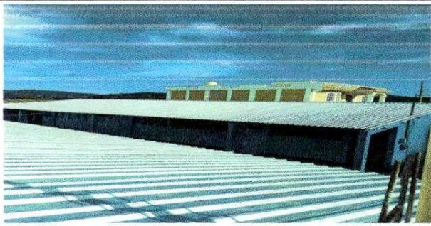
Foto1: colocación de lamina torquelad aluzinc calibre 26 en el are de el modulo 1 y 2
